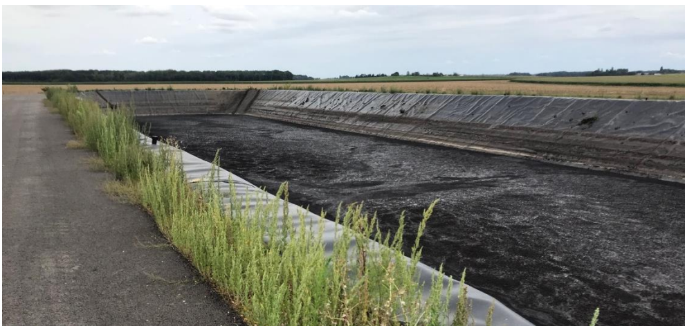
Figure 5 : Lagune de stockage du digestat liquide lors de la campagne
